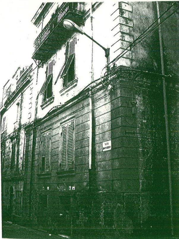
Foto 7. Prospetto Via Rosario
