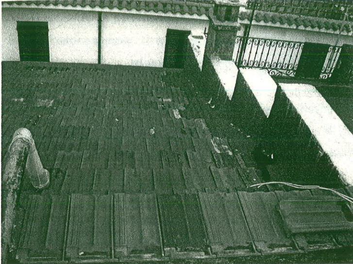
Foto 6. Particolare copertura e terrazzo
